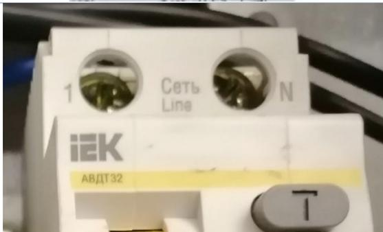
**Клеммы** аппарата промаркированы и подписаны (Сеть/ Нагрузка), что позволяет избежать ошибок при монтаже.
