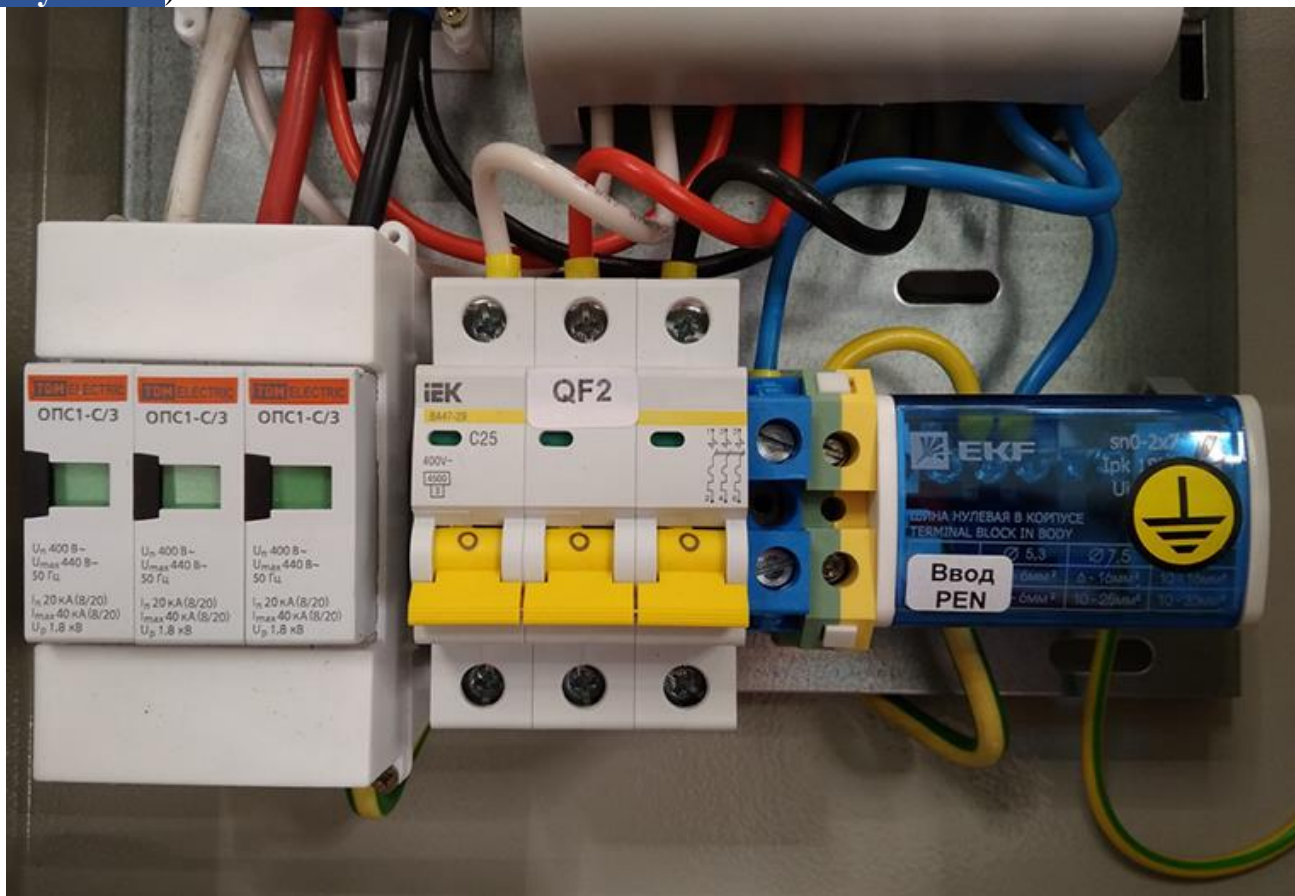
Рисунок 18. Установка разрядников
